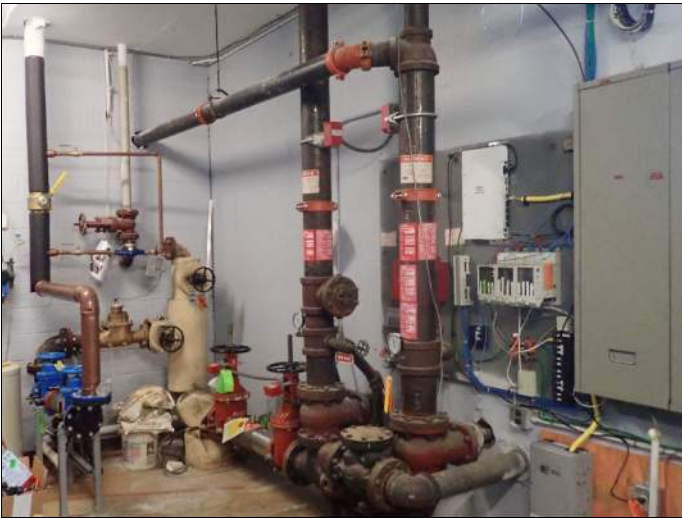
Fire sprinkler risers
